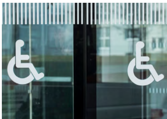
Fot. 5. Oznaczenie szklanych drzwi wejściowych z uwzględnieniem potrzeb osób z niepełnosprawnościami. Źródło: www.canva.com
