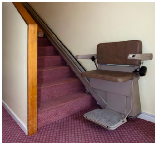
Fot. 4. Przykład montażu windy schodowej w hotelu.
