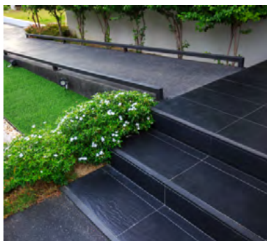
Fot. 8. Rampa do obsługi osób poruszających się na wózkach inwalidzkich.
